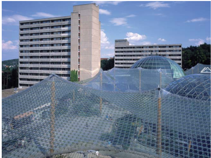
Außenbereich mit „Olympiadach“ am Rhön-Klinikstandort Bad Neustadt an der Saale
